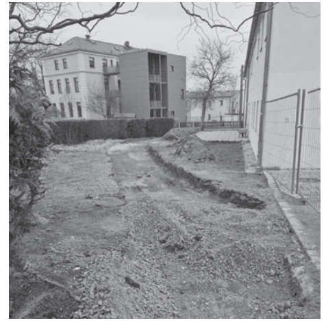
Bau des Weges am Hort in Reichenberg
