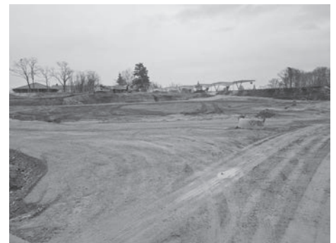
Baubeginn der neuen Reithalle in Moritzburg
