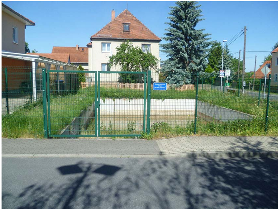
vorhandenes Regenrückhaltebecken – 1. Bauabschnitt
