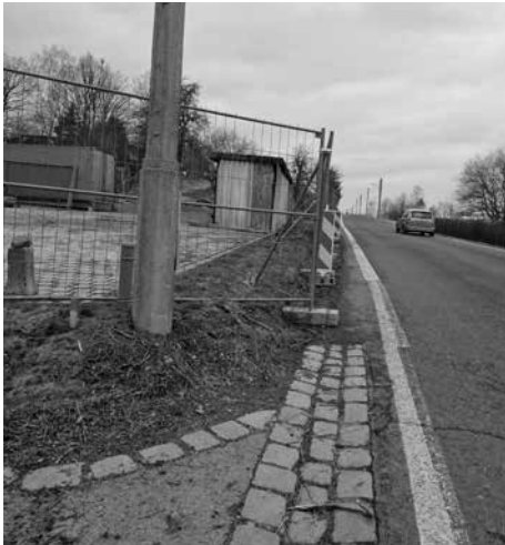
Baustelle Schulweg Großer Gallberg
