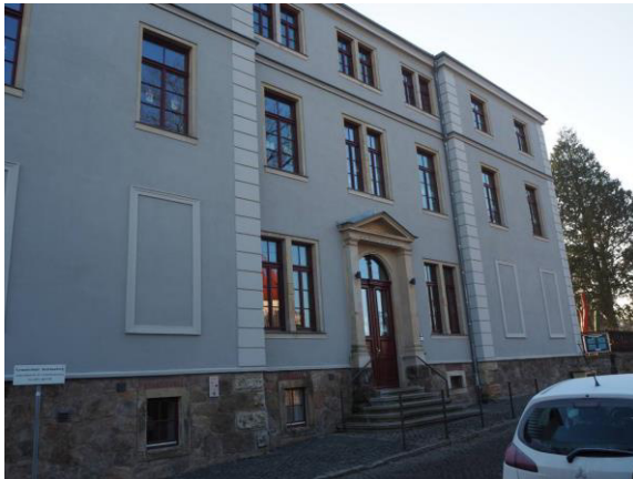
Foto: Haupteingang Grundschule Reichenberg (Aufnahme: 03/2019)
