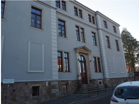
Foto: Haupteingang Grundschule Reichenberg (Aufnahme: 03/2019)
