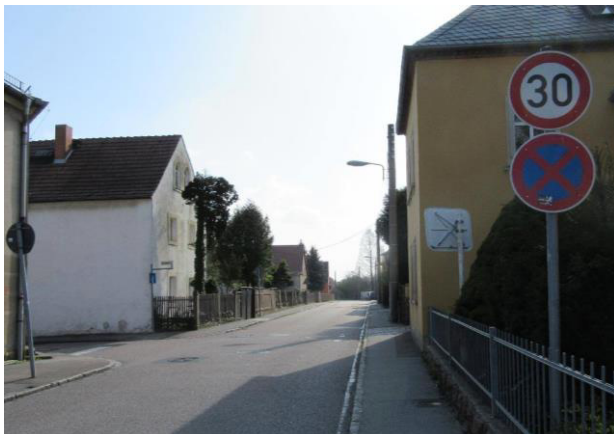
Foto: Schulstraße Richtung Dresdner Straße (Aufnahme: 03/2019)
