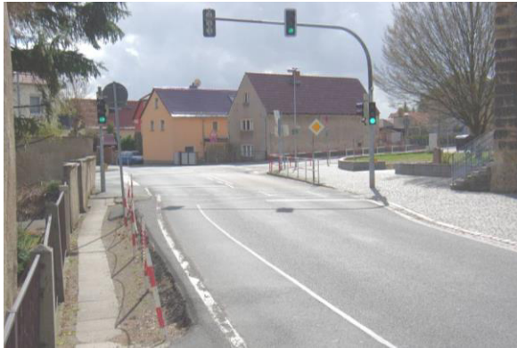
Foto: LSA-gesicherter Übergang über Großer Gallberg (Aufnahme: 03/2019)
