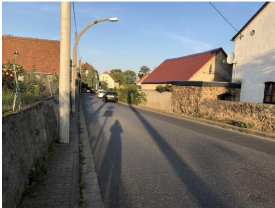
Foto: Engstelle Großenhainer Straße ohne Möglichkeit zur sicheren Begehung (Aufnahme: 09/2020)
