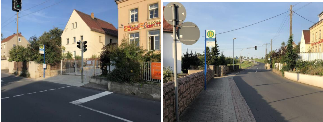
Fotos: links: kleine Aufstellfläche/ Haltestelle vor Schuleingang, kurzes Geländer; rechts: schlechte Sichtbeziehung des rechtsseitigen Haltestellenbereichs (Aufnahme: 09/2020)
